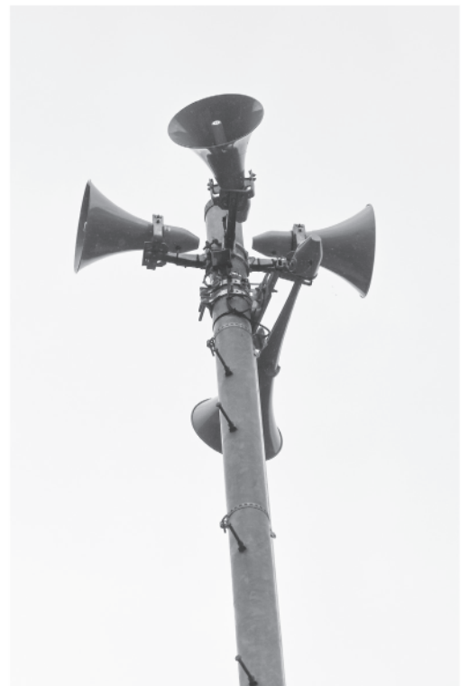
▲防災無線外部スピーカー
