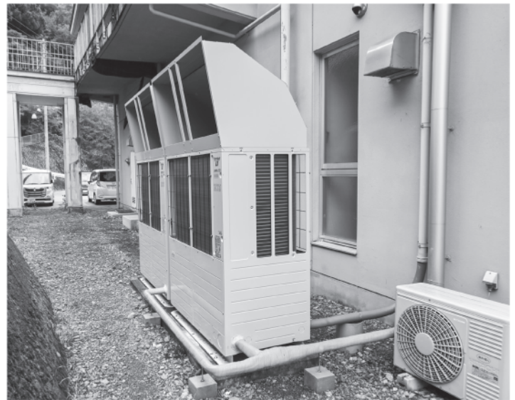
▲福祉センターエアコン改修工事(繰越)
