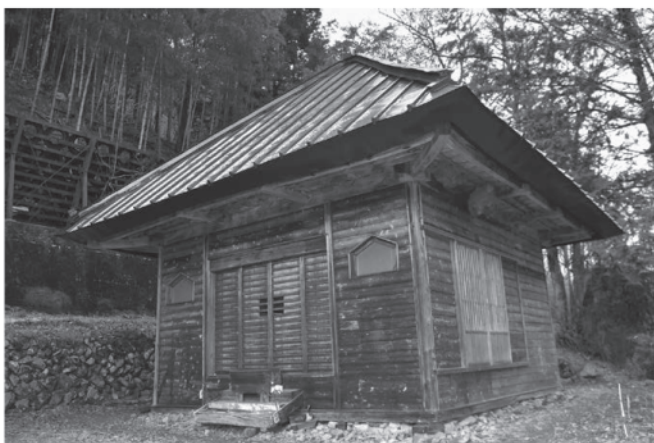
▲保之瀬薬師堂の屋根の補修
