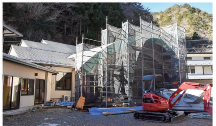
▲交流センター改修工事
