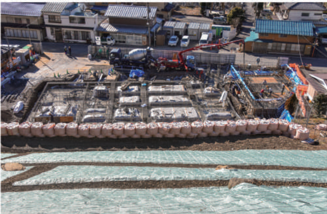
▲新庁舎建設工事
