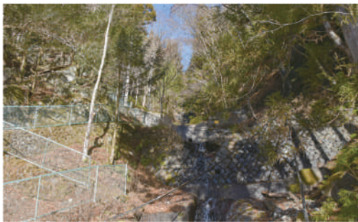
▲保之瀬取水修繕
