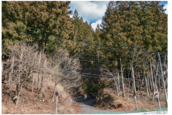
▲重要インフラ施設周辺森林整備事業（上：国道沿 下：山王沢）
