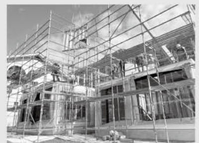
▲建設工事中的の様子
