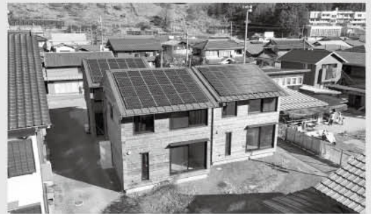
▲完成したモバイル建築住宅（ドローン撮影：一般社団法人日本モバイル建築協会提供）
